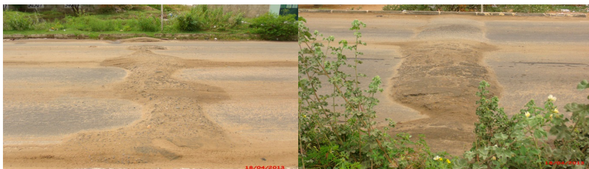
A-3 – Lombadas de 1,80m deterioradas e a 30m uma da outra na Estrada da Banana
