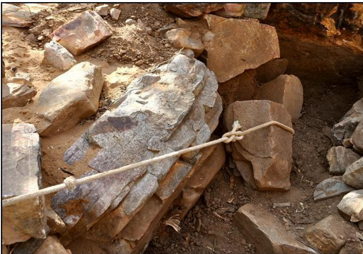
Figura 18 – Retirada de matacão angular, na sondagem, à montante do muro de arrimo
