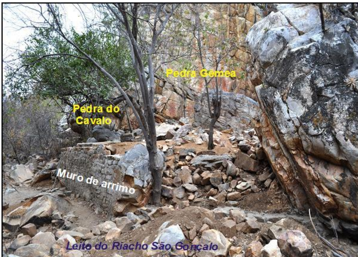
Figura 25 – Início da edificação do muro de arrimo
