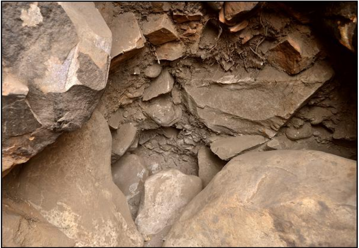
Figura 16 – Sedimentos evidenciados na escavação para as fundações do muro de arrimo
